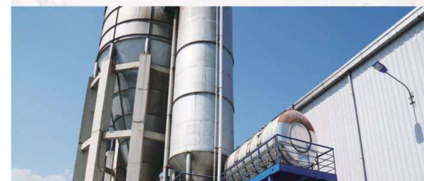
Water Recycle System / 廢水廢料回收再利用系統
